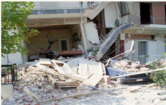
EuroNews 8/8/99-ΣΕΙΣΜΟΣ ΣΤΗΝ ΑΘΗΝΑ-ΦΩΤΟ ΑΠΟ ΚΑΤΑΡΕΥΣΗ ΚΑΤΟΙΚΙΑΣ ΣΤΟ ΜΕΝΑΙ
